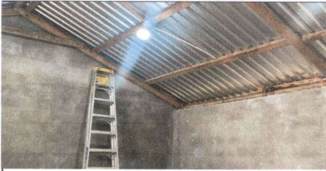
Foto 7. Reparación de repello y cernido de pared, en la cocina
