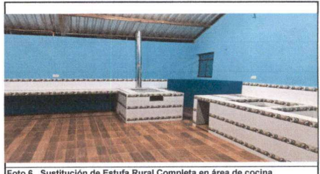
Foto 6. Sustitución de Estufa Rural Completa en área de cocina
