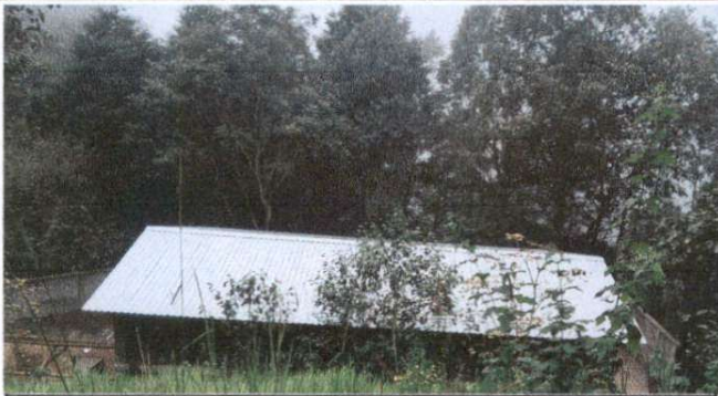
Foto 1: Sustitución de Lamina por lamina troquelada, aulas segundo nivel
