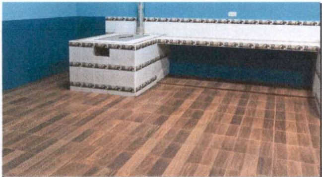
Foto 3: Sustitución de piso de torta de concreto por ceramico, en área de cocina
