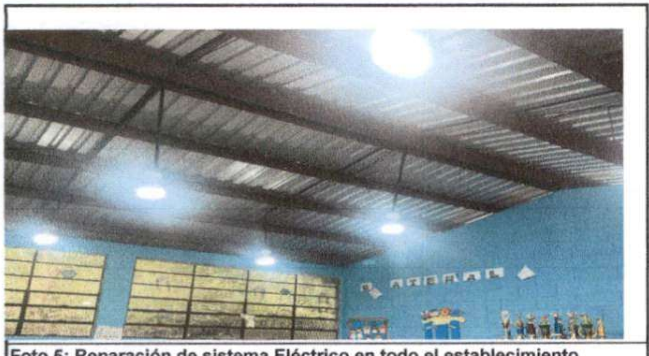
Foto 5: Reparación de sistema Eléctrico en todo el establecimiento
